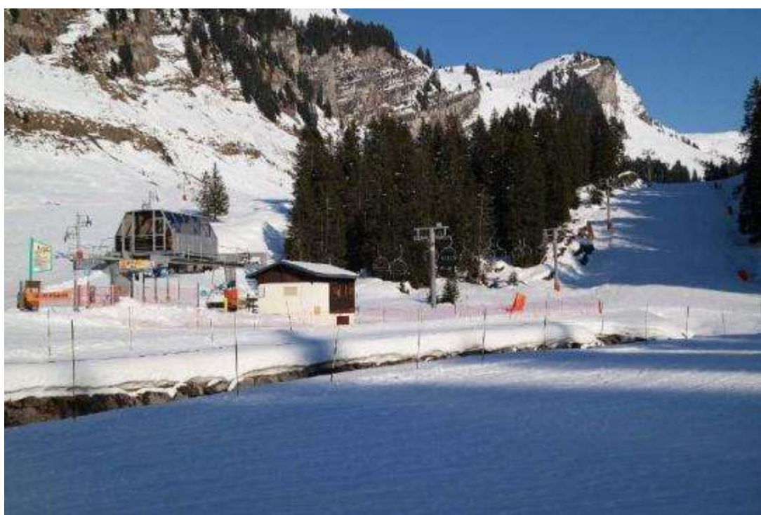
Gare de départ et vue sur la ligne depuis le bas aux 2 saisons
