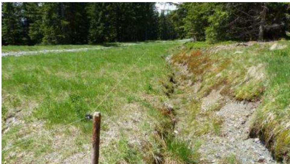
Drain le long de la piste à reconnecter pour favoriser l'alimentation du secteur aval Epode le 07 juin 2017
