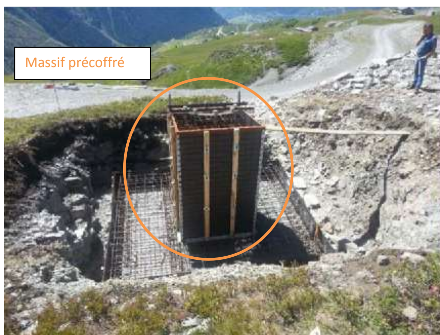
Photo de chantier TSD Plan du Repos – La Rosière 2014 (source DSR)
