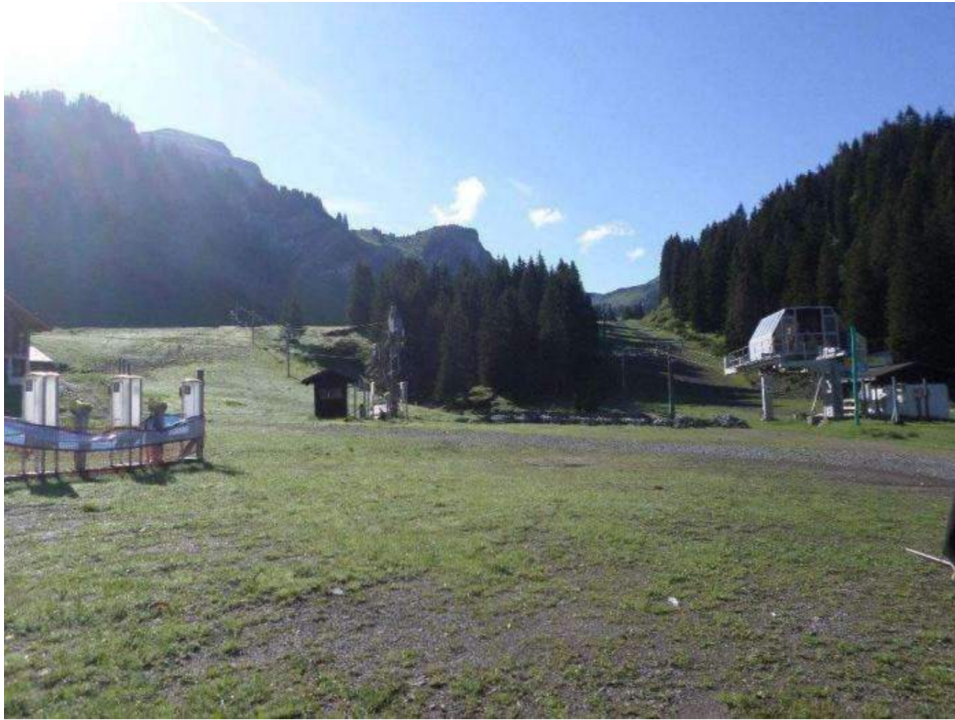
Gare de départ de la Léchère à l'état actuel EPODE – Décembre 2017
