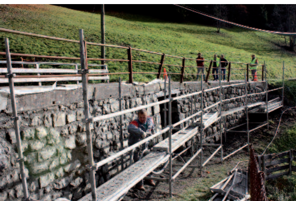
La réfection du Pont de Bellecombe a eu lieu cet automne 2010
